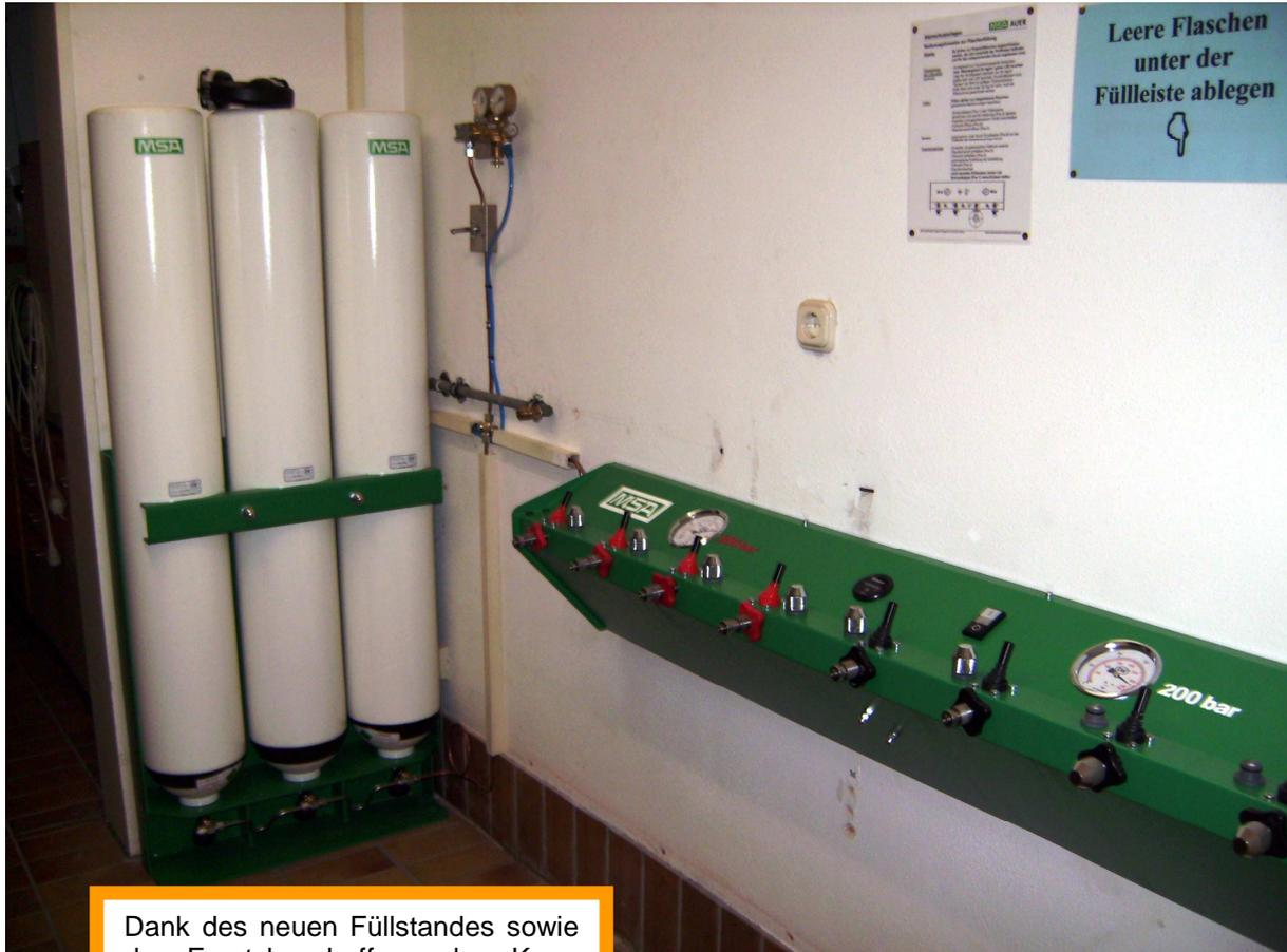
Dank des neuen Füllstandes sowie der Ersatzbeschaffung des Kompressors ist es für den Atemschutzgerätewart nun kein Problem mehr, die bei Übung und Einsatz geleerten Flaschen wieder neu zu füllen.
